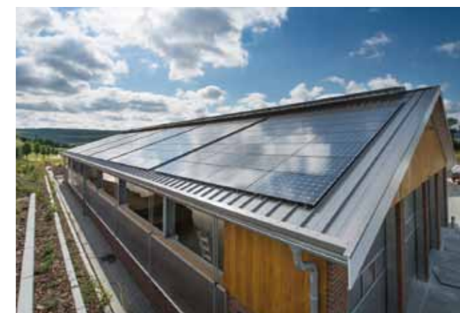
Im Projekt steht die Zuverlässigkeit von Wechselrichtern im Mittelpunkt. Sie wandeln die Gleichspannung der angeschlossenen Solarmodule in Wechselspannung um.
