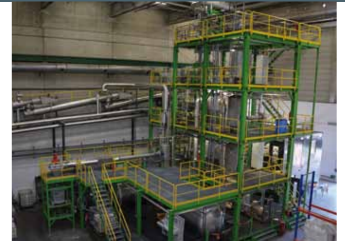
CARBOLIQ-Pilotanlage zur Verölung von aus Haus- und Gewerbemüll gewonnenen Ersatzbrennstoffen im Entsorgungszentrum Ennigerloh.
